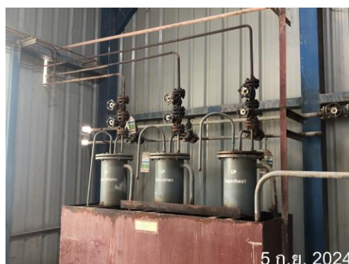
รูปที่ 44 ระบบท่อตรวจวัดคุณภาพน้ำ
